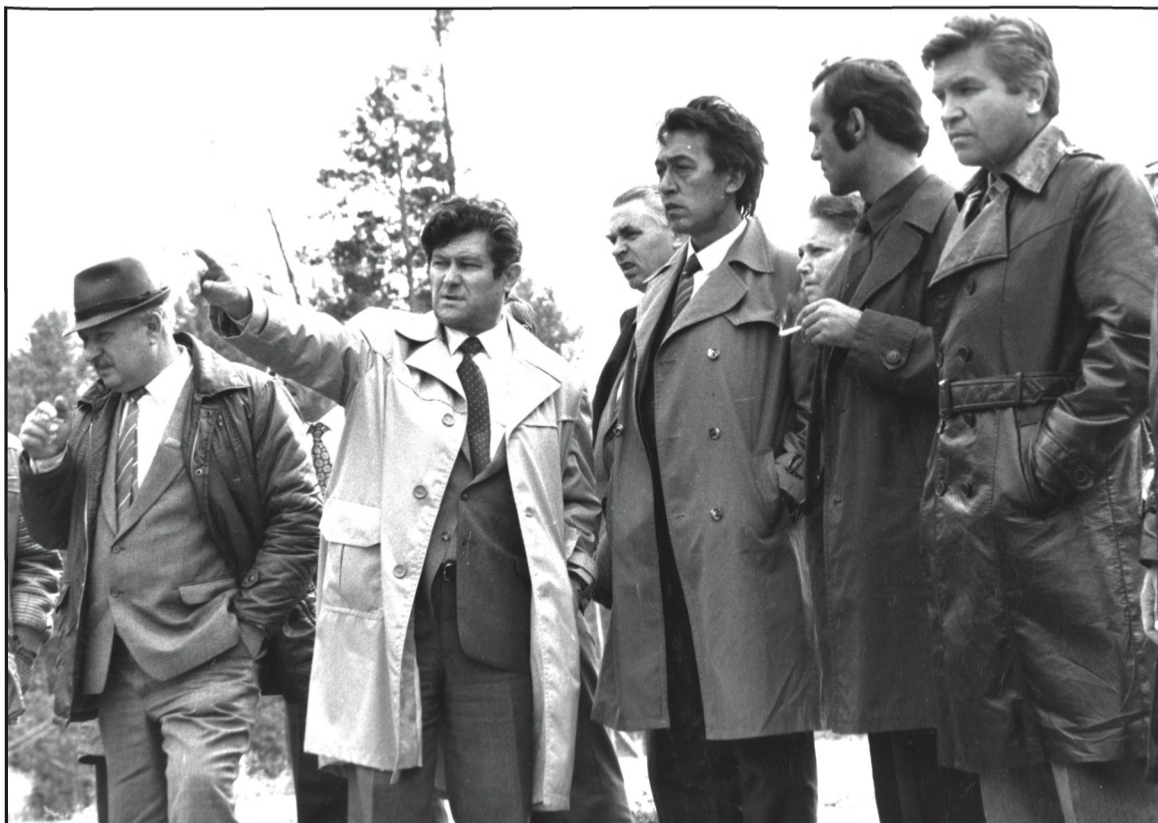
■ Руководители стройки и БратскГэсстрой накануне первой очереди перекрытия котлована. Кодинск, 1981 год
