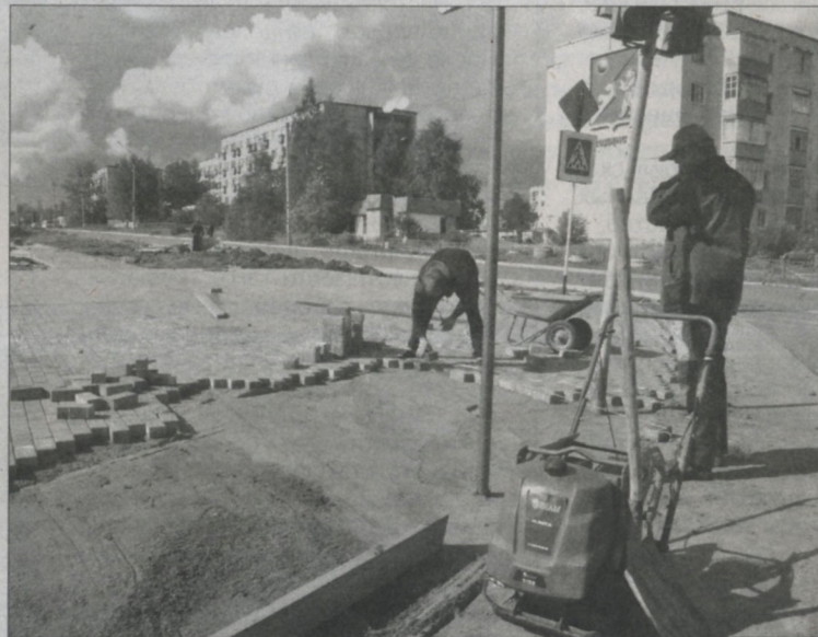
■ Идут работы по строительству сквера
